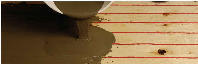
FIGURE 2.42 : Méthode du mélange autolissant
