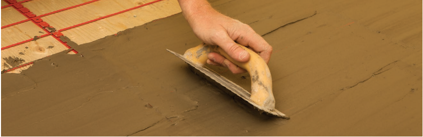
FIGURE 2.52 : Méthode du mortier à pose simplifiée
