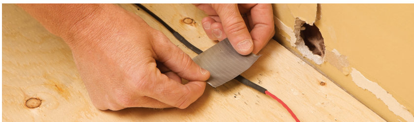
FIGURE 2.23 : Fixer le conducteur froid au faux plancher
