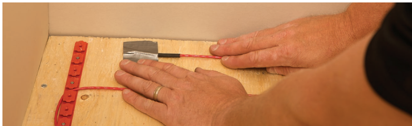
FIGURE 2.28: Fixer l'embout protecteur
